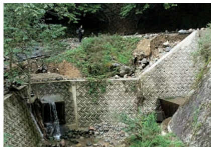
写真 宮神山田線カルバート合流部
