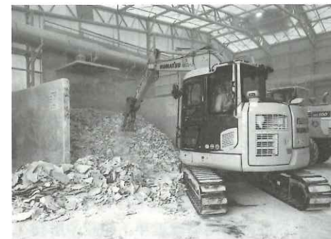
受け入れた廃石膏ボード
